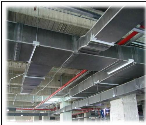
1. 燁輝抗菌環保鍍面鋼品主要應用於空調系統，其表面之奈米抗菌防黴處理層可有效抑制細菌與黴菌生長，避免有害微生物於整體空調系統中繁衍，進而汙染室內空氣品質。
